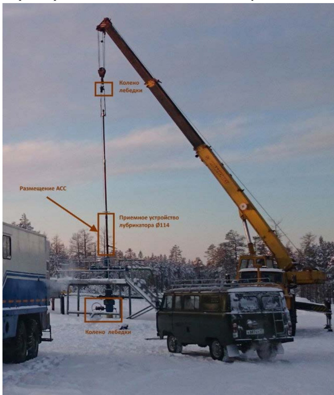
Рис.2 Постановка АСС в скважину
