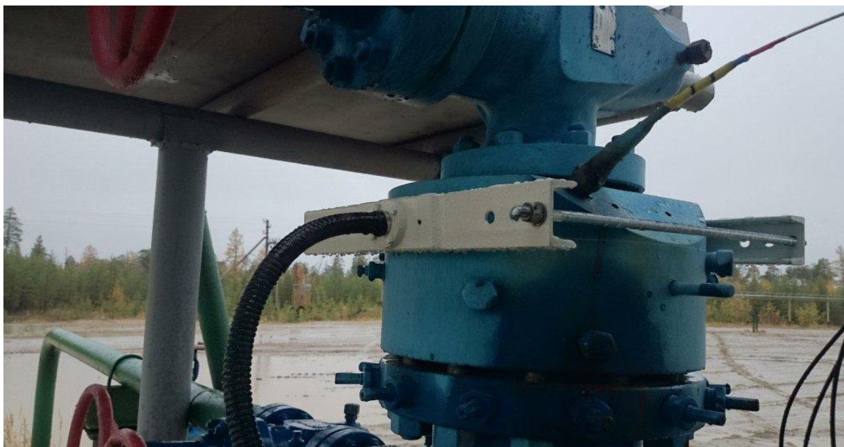
Рис 4. Устройство приема акустического сигнала
